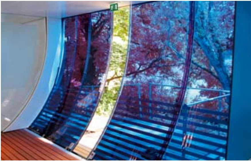
Schiebetüren aus gegossenem und thermisch verformtem Acrylglas, Ericsson Pavillon
